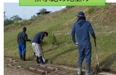
排水路の泥上げ
